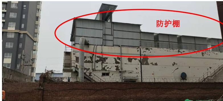
项目南侧（渭南通创水务运营有限公司东水厂）
