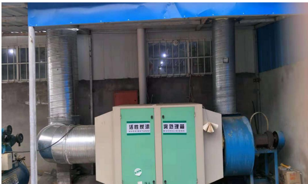
风机设置减振垫、软性接头、加装隔声罩
