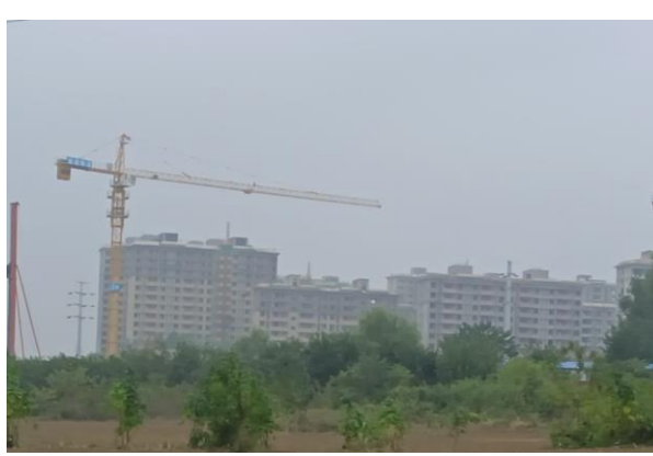
项目北侧渭南市美好生活示范区康复康养中心（在建）
